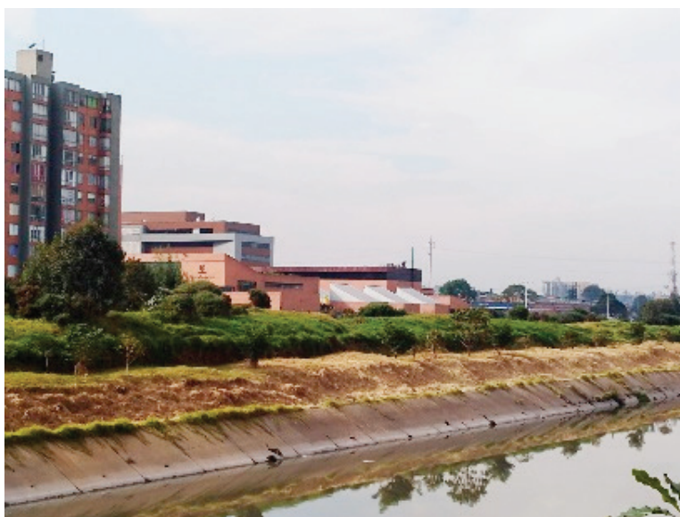
Figura 2. Canal San Francisco
