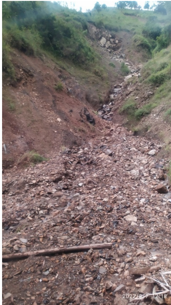
Figuras 10. Derrumbes en las vías de acceso al Norte de Caldas
