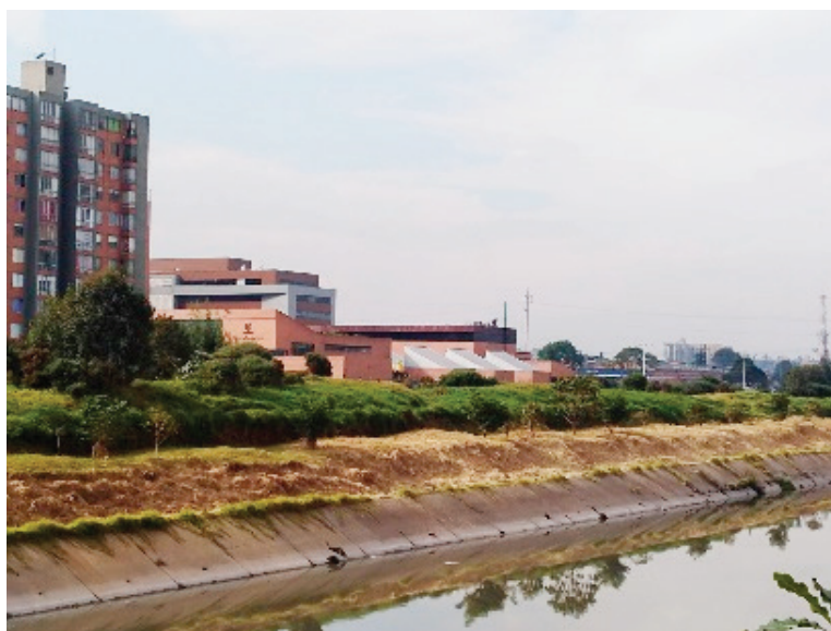
Figura 2. Canal San Francisco
