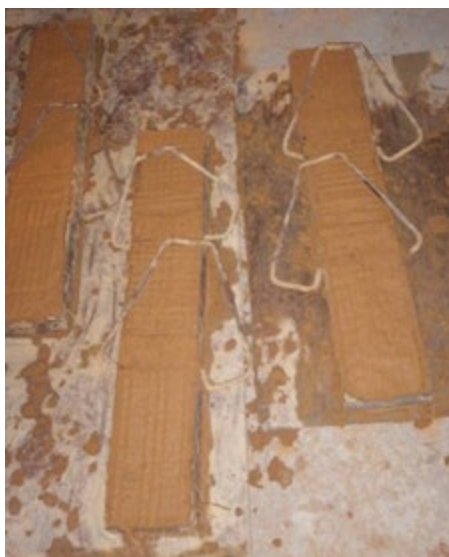
Figura 13. Moldeado de ladrillos, mezcla 1 húmeda
