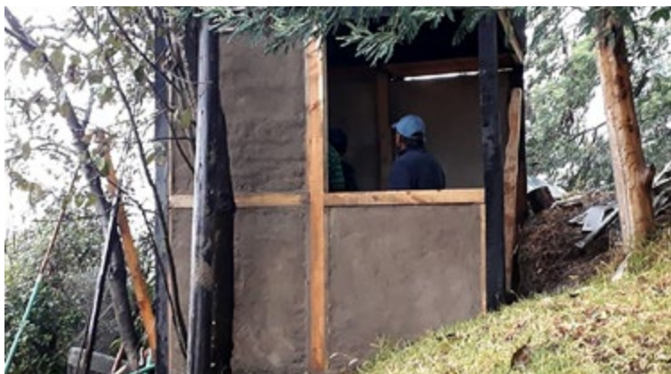
Figura 3. Construcción muro en Bahareque.
