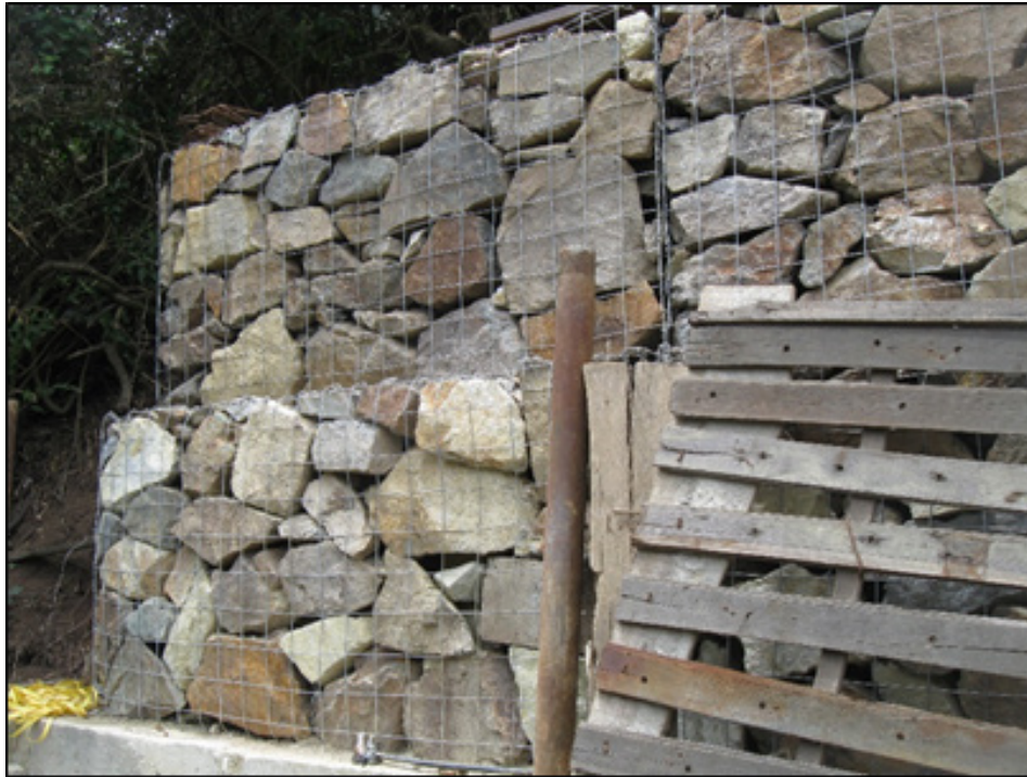
Figura 1. Utilización de agregados gruesos como gaviones.
