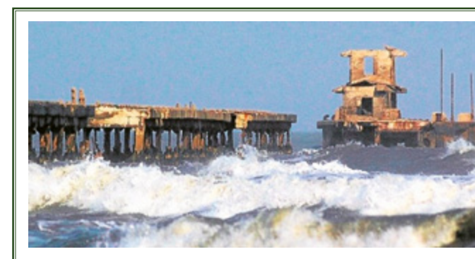
Muelle de Puerto Colombia. 20
