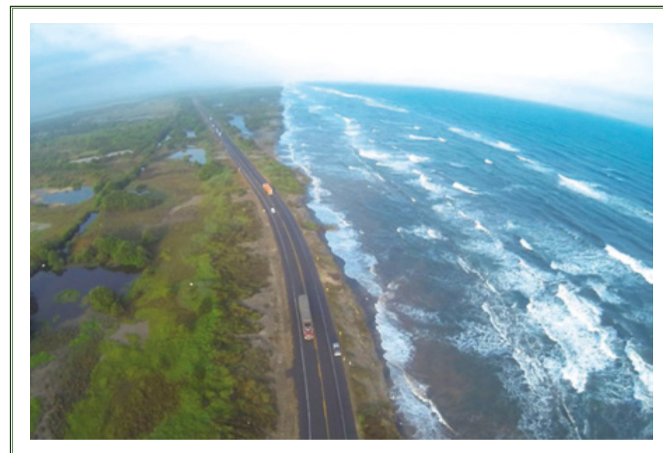
Peligra la carretera Barranquilla-Ciénaga.
